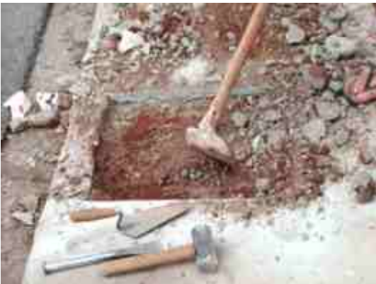
Foto 5 - ... Abriam os canteiros de 50x 50 cm, retirando o concreto...
