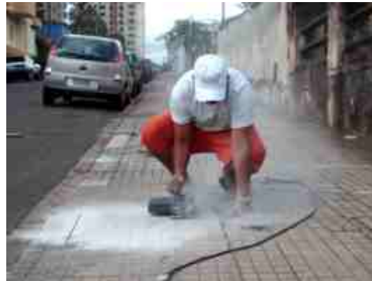
Foto 4 - Nos locais demarcados para plantio, os pedreiros rasgavam a calçada com a serra circular...
